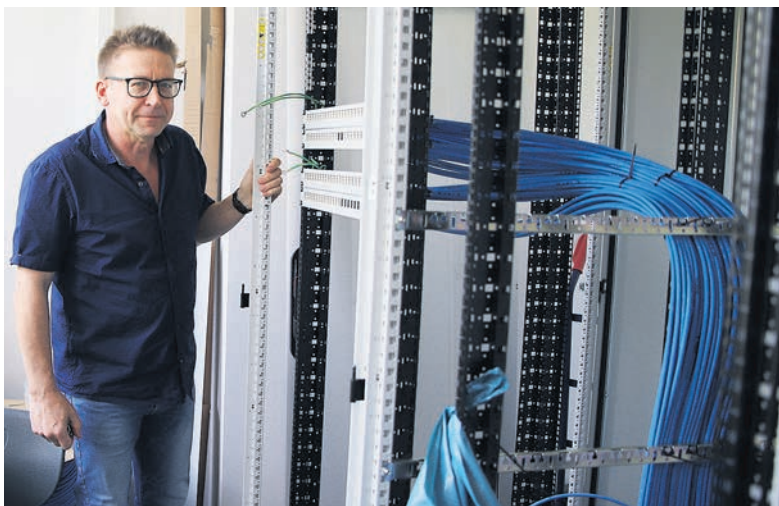
Ralf Gräbner ist der stellvertretende Leiter der Europaschule Storkow. Hier steht er im neuen Serverraum, der gerade gebaut wird.
